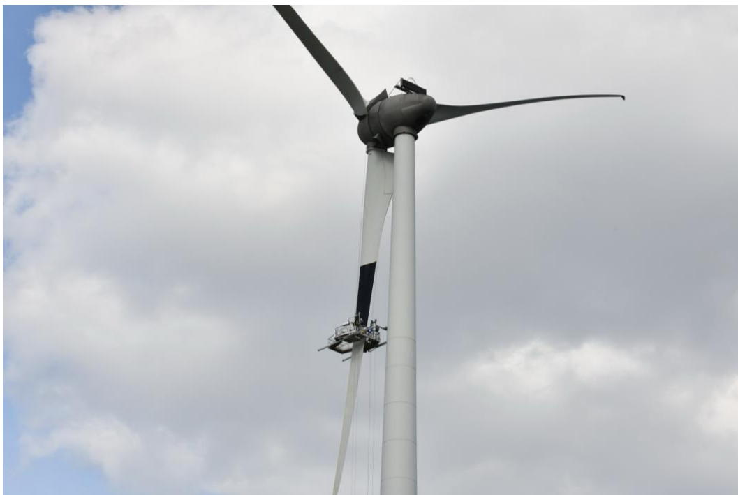
Figuur 4.1 Het zwart verven van een wijk in september 2022. Foto: Alex Wiersma, provincie Groningen.
