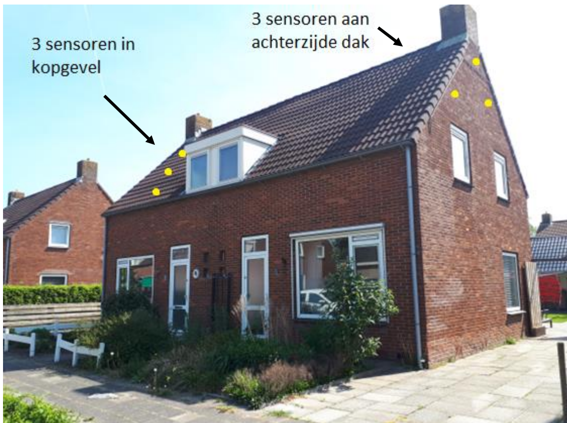
Figuur 2.1. Meetopstelling (plaatsing van de sensoren) op het dak en in de muur.
