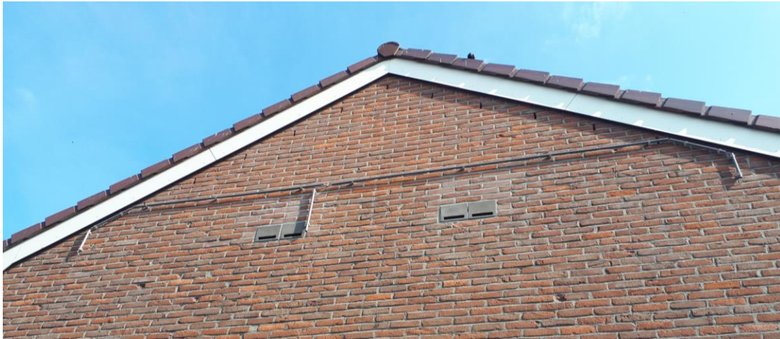
Figuur 2.4. Plaatsing van de meetsensoren in de spouwmuur aan de kopgevel van woning 8. De middelste sensor is in de inbouw-vleermuiskast geplaatst.
